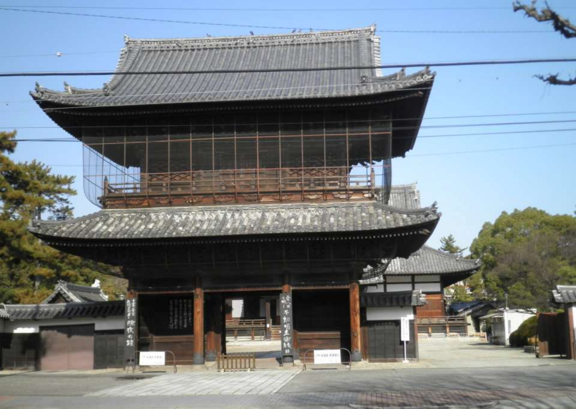
徳川家霊廟の「建中寺」 愛知県指定文化財で 平成23年度～27年度 保存修理中の看板があった
